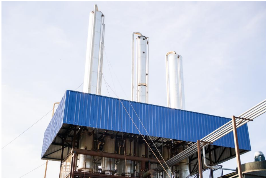
Figura 8 - Torre de destilação.
