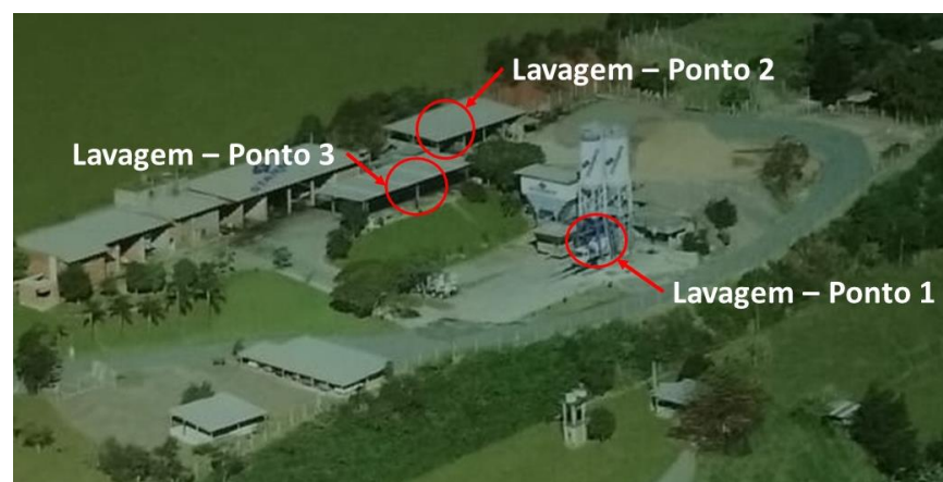
Figura 5 – Pontos das lavagens dos caminhões betoneiras da Empresa A
