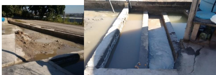
Figura 4-Tanques de coleta da água residual existente na Empresa A
