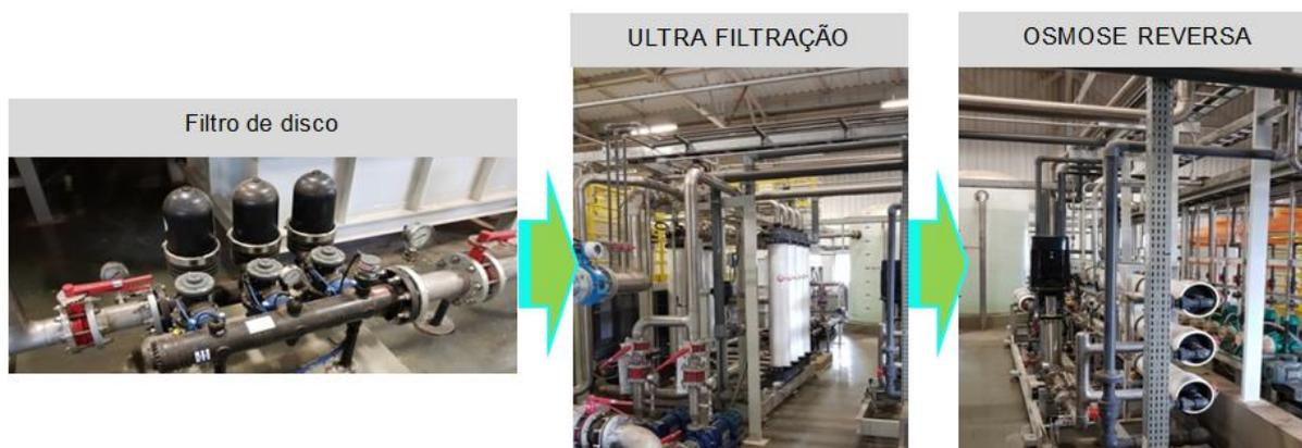
Figura 11- Sistema de reuso com visualização dos skids de ultra filtração e osmose reversa
