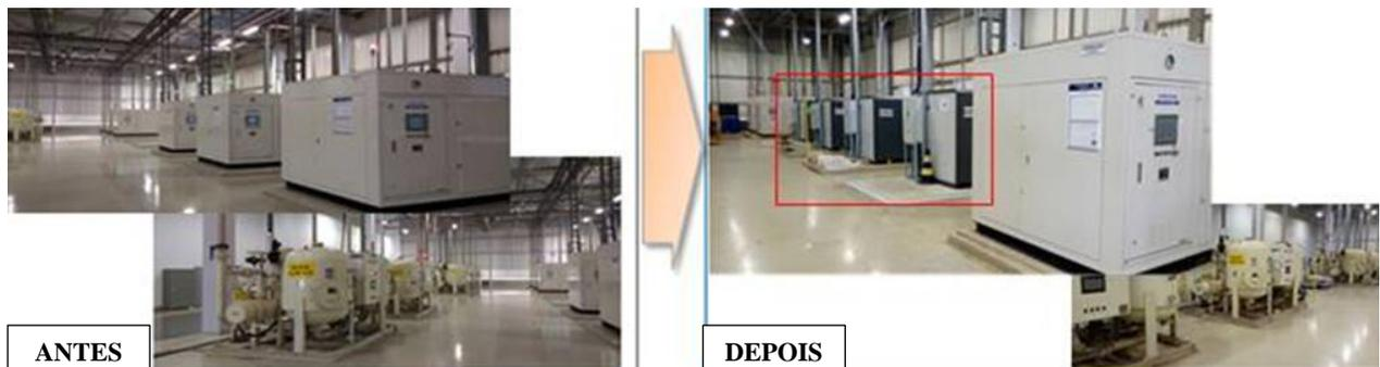
Figura 13 – À esquerda situação antes da troca dos compressores. À direita, novos compressores instalados
