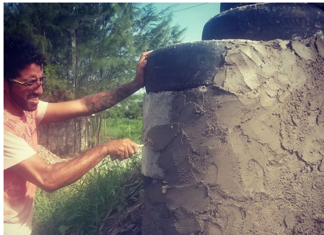
Figura 12: Acabamento das paredes de pneus.
