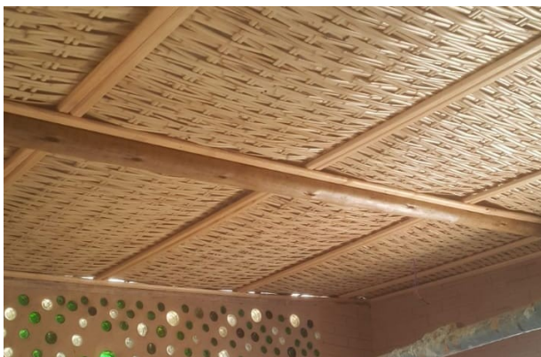
Figuras 13 e 14: Cômodos da Casa PAS, um bambu no forro do teto.
