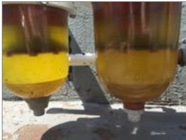
Figura 19 Filtro separador com excesso de água e sedimentos, sem drenagem.
