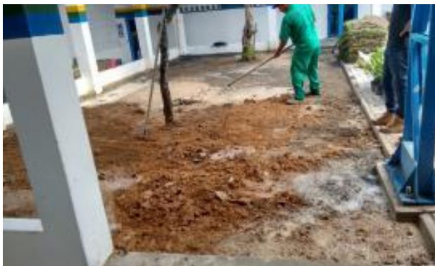
Figura 6: Construção do jardim executado pela FCA na escola Cecília Maria Vaz Curado.
